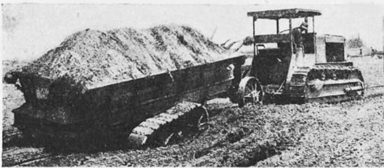
Гусеничный трактор с гусеничной прицепкой на дорожных работах
